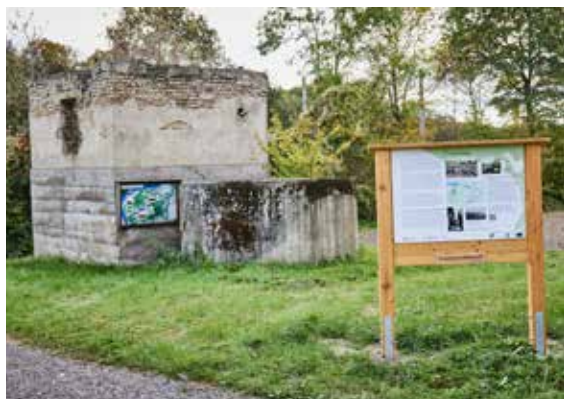
Das Pumphäuschen steht auf halber Höhe zwischen dem Hafen und der Bahnunterführung vor Wallenbach.
