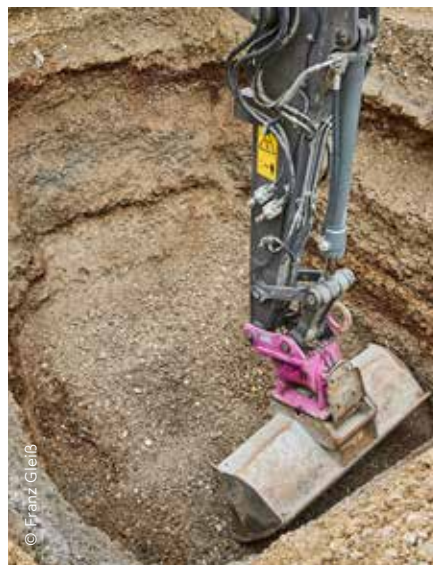
Bis in zweieinhalb Meter Tiefe wurden die Sickerschächte in den Schotterboden gegraben.
